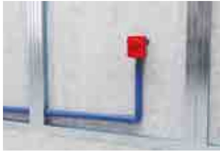
2. Соединить выпуск корпуса сифона с системой канализации.
