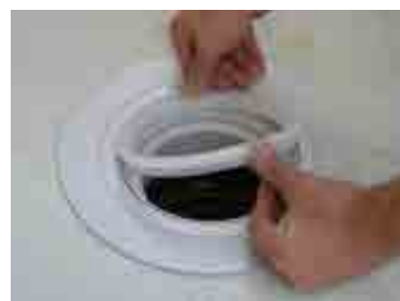
9. Убедиться в правильности установки прозрачного пластикового кольца
