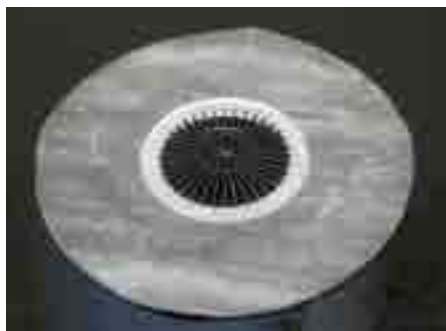
2. Нанести праймер, наклеить 1-й слой гидроизоляции
