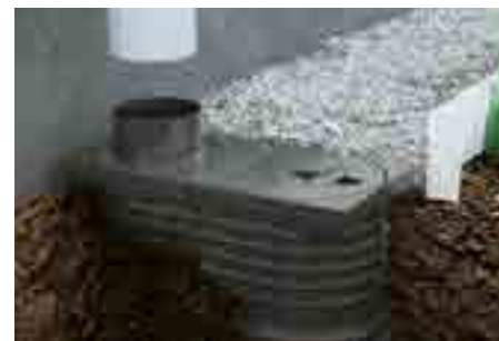
3. Присоедините водосточную трубу
