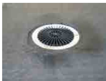
5. Так должна выглядеть воронка после укладки гидроизоляции
