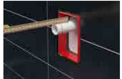
6. Отметить на резьбовой патрубке расстояние 3 см, измеряться от поверхности стены (плитки)
