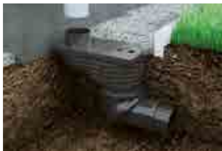
1. Установите дождеприёмник
